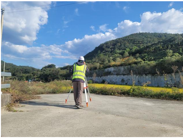
광파기를 이용한 측량 작업사진
